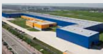
Hörmann Tianjin, Cina
