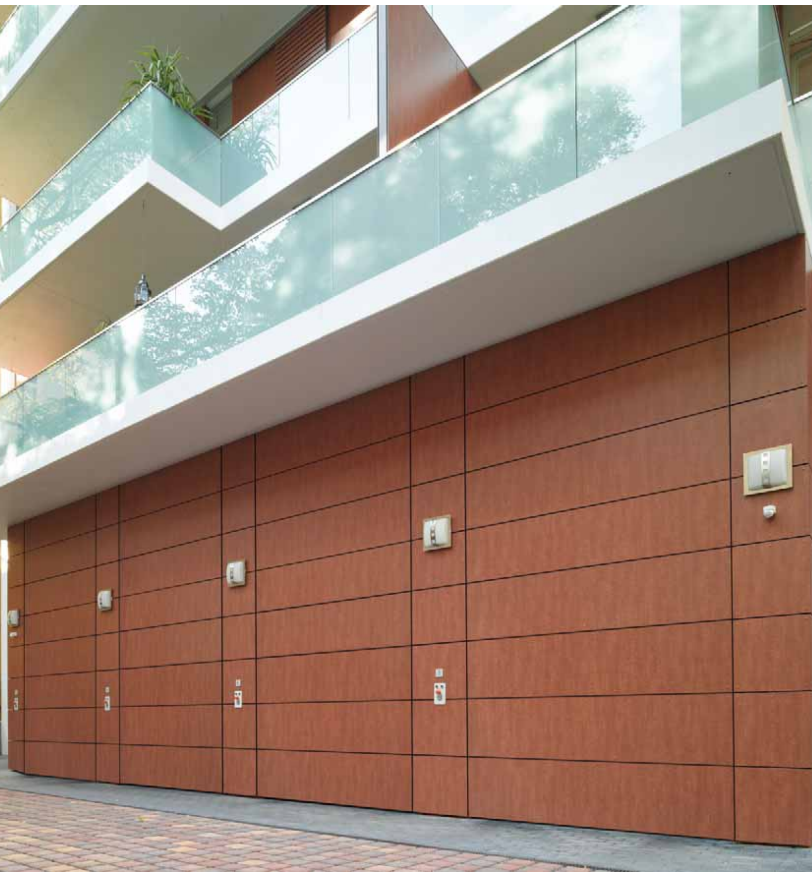
Rivestimento esterno a cura del cliente con pannelli di legno impregnato
