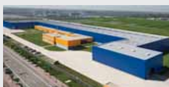
Hörmann Tianjin, Cina
