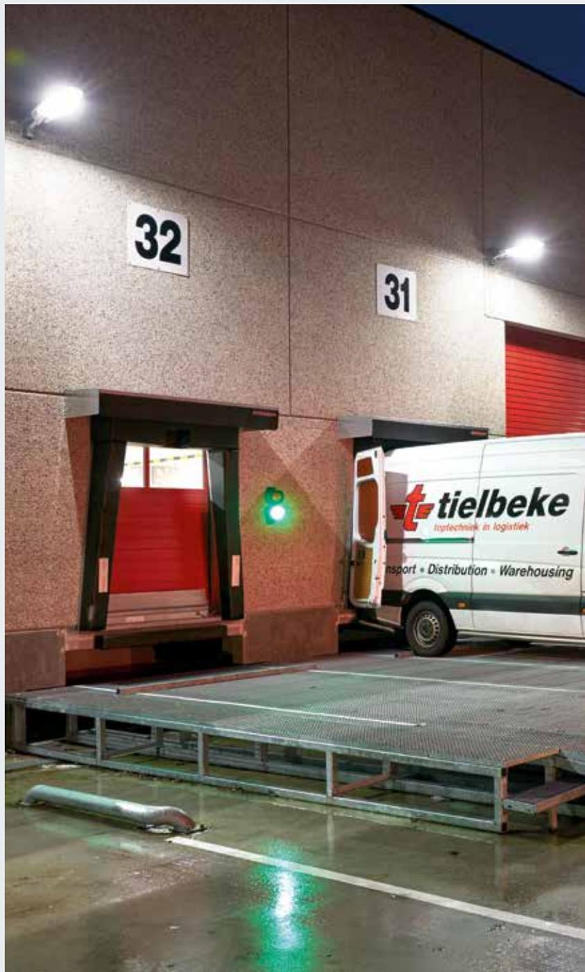
Se tutte le pedane devono essere alla stessa altezza, la regolazione del livello della corsia è una buona soluzione per compensare le differenze di altezza delle superfici di carico dei vari automezzi.
