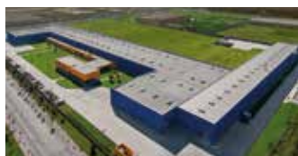
Hörmann Tianjin, Cina
