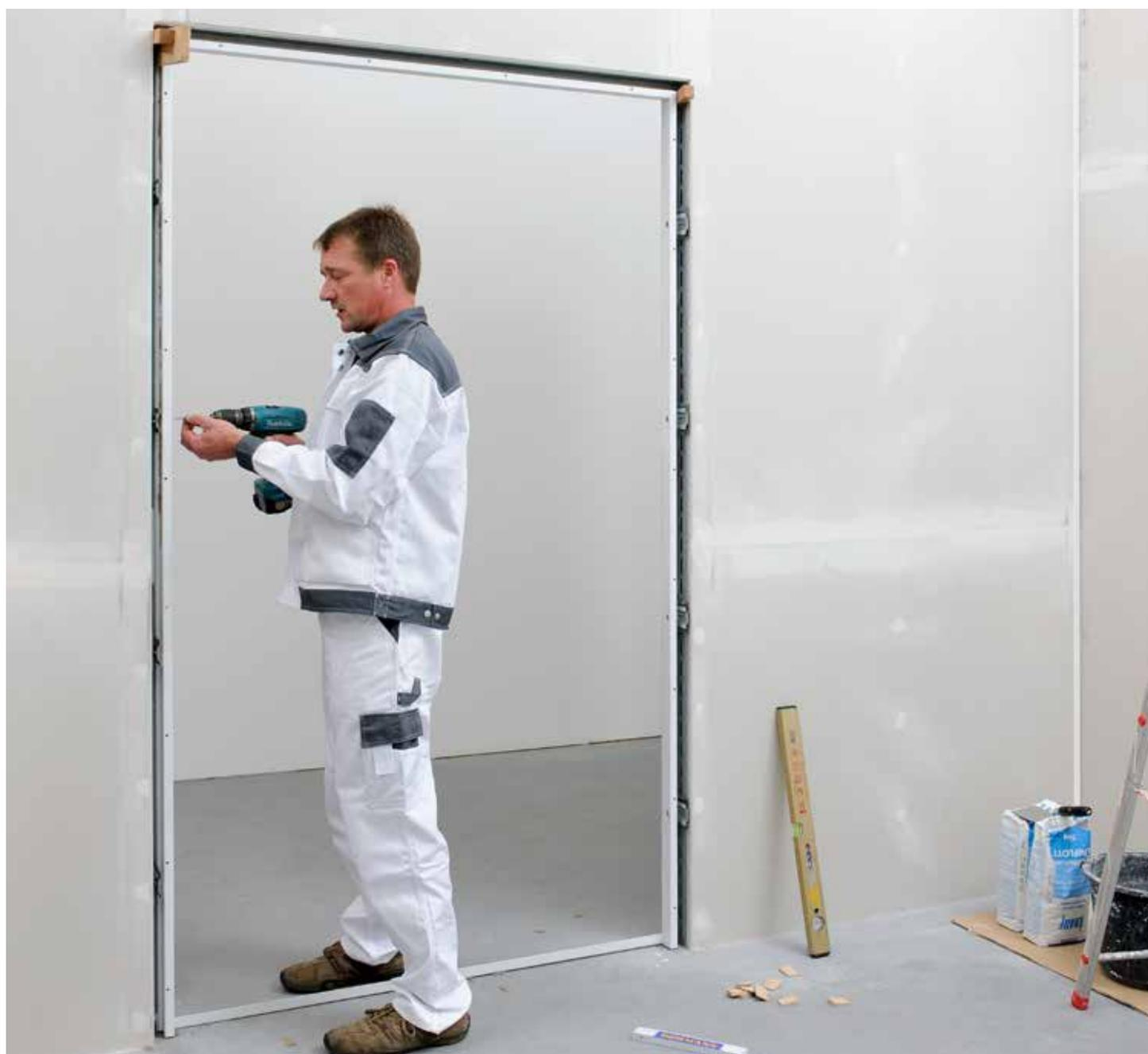
Con i nostri telai ad angolo standard **1**, è possibile montare le porte per edifici industriali e residenziali OD in modo più veloce, semplice e flessibile. Come standard, il telaio viene montato rapidamente mediante fissaggi diagonali con solo pochi pressacavi. Grazie ai kit di montaggio opzionali, il telaio può essere adattato con facilità a diverse situazioni di montaggio.
